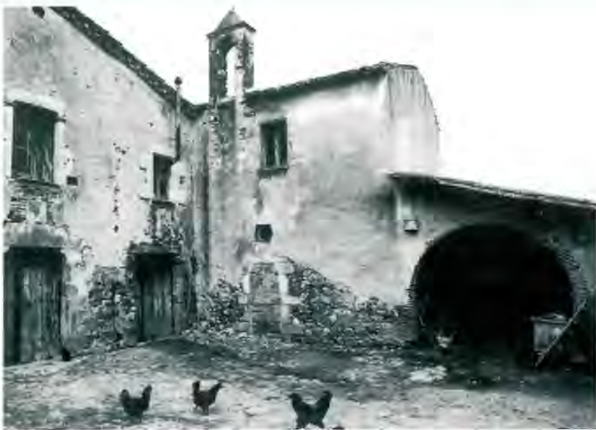
Fig. 85. El mas Vilabella del barri d'Esclet, al sud-oest del terme de Cassà de la Selva, va ser propietat del monestir guixolenc fins a la desamortització de mitjan segle passat. Fotografia de l'Arxiu Segur.
