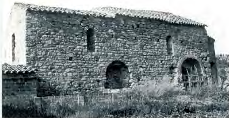
Fig. 33. Vista lateral des del migdia de l'església de Santa Maria de Fenals o església vella de Fenals d'amunt.
