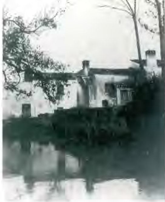
Fig. 91. El molí de Sa Lixarda de Castell d'Aro és situat al marge dret del Ridaura, al peu del camí que va de Bufaganyes a les Aroles. Avui tot l'indret ha estat transformat i quasi no en queden rastres. Fotografia dels anys quaranta del AHMSFG.
