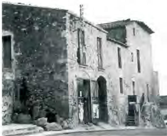
Fig. 42. Restes de l'antic castell de Benedormiens (Castell d'Aro), abans de començar la seva restauració als anys setanta.
